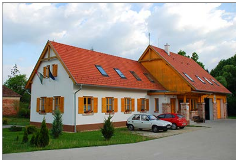
Az őriszentpéter mentőállomás modern épülete Óriszentpéter (Alszer)
